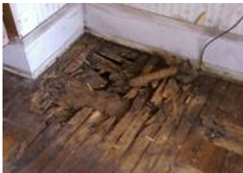
Remove untenable flooring
